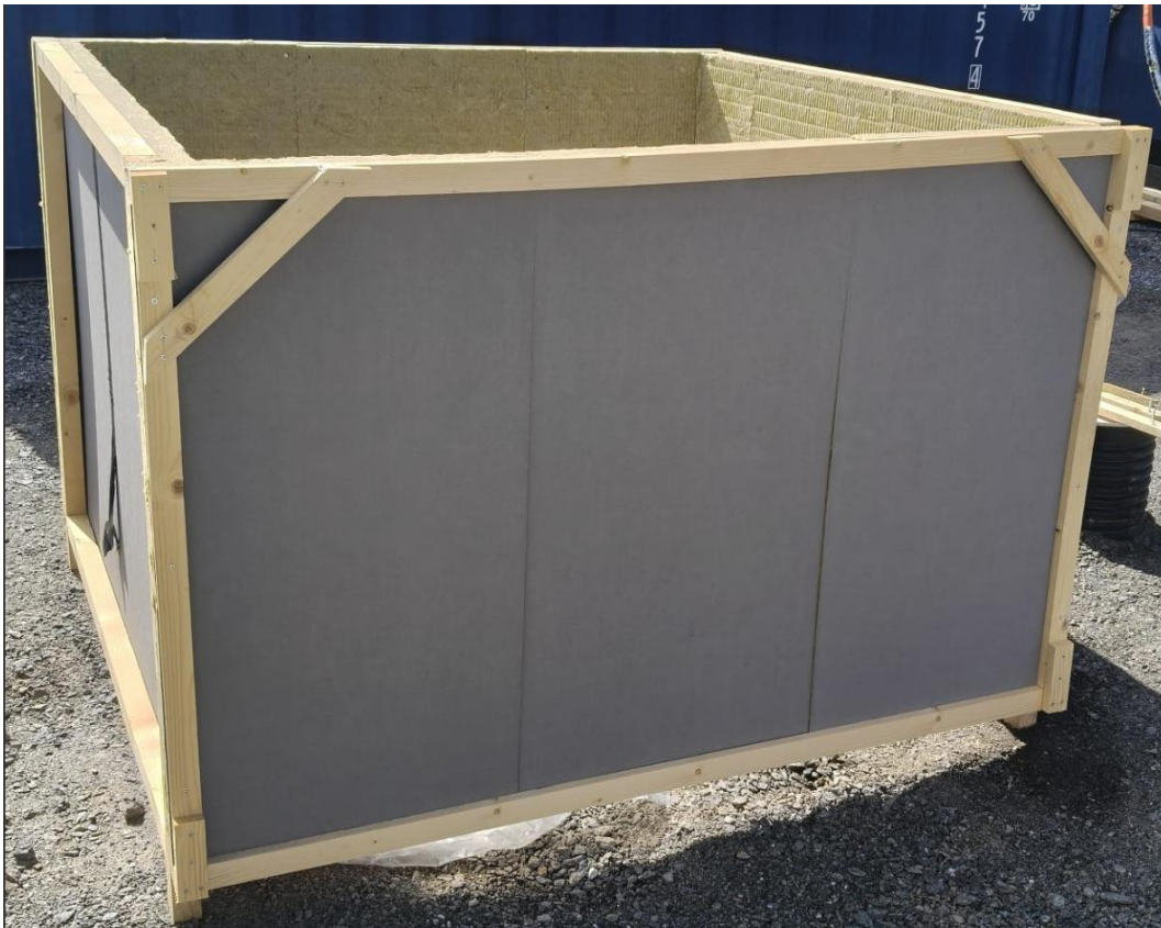
Kuva 1. Kaivantojen kuivattamisessa käytettyjen aggregaattien melua rajoitetaan kuvan mukaisilla meluseinillä.
